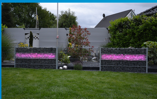
Gabione teilweise mit Schotter und Glas bestückt. LED-Beleuchtung schon integriert.
