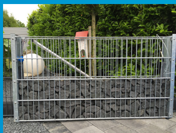
Gabione teilweise mit Schotter bestückt.
