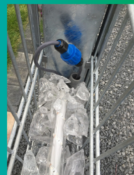
LED Rohr wird mit Glassteine bestückt. Die elektrische Verbindung gut zu sehen
