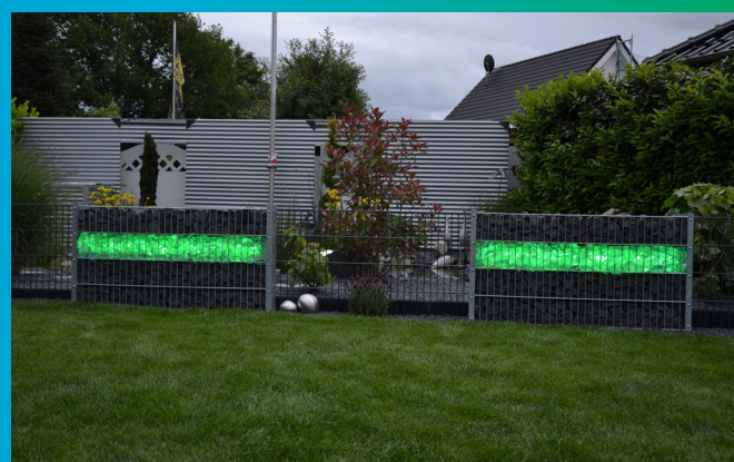
Gabione teilweise mit Schotter und Glas bestückt. LED-Beleuchtung schon integriert.
